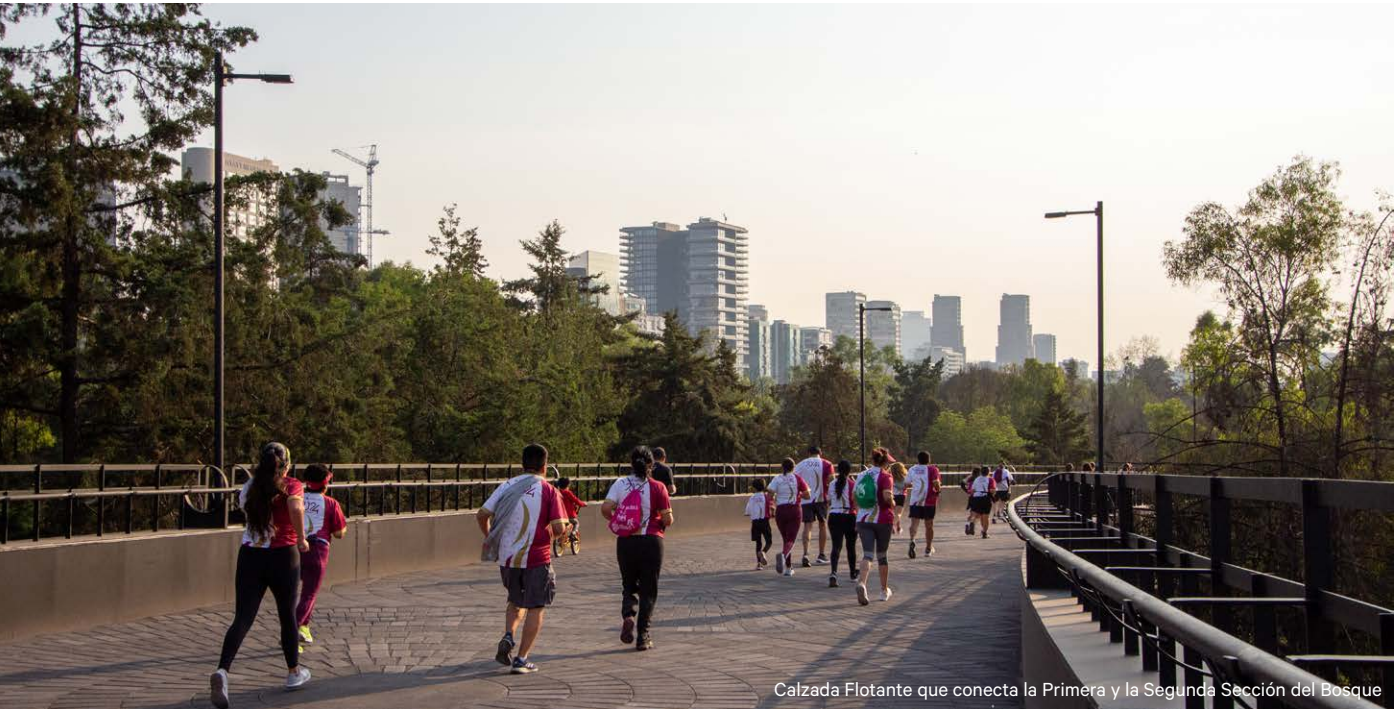
Calzada Flotante que conecta la Primera y la Segunda Sección del Bosque
